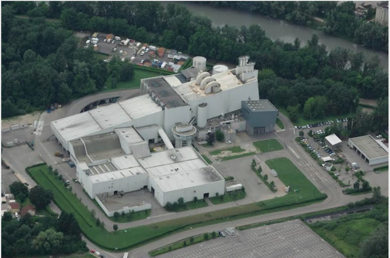
Les feux de câbles sont observés à proximité du centre de tri Athano, à la Tronche. © Grenoble-Alpes Métropole – Centre de tri Athanor
