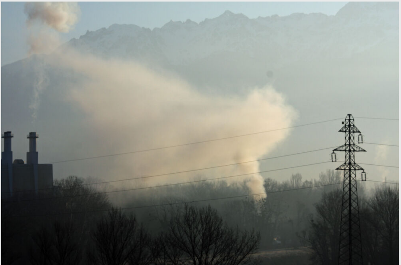
Un habitant de La Tronche photographie très régulièrement les feux de câbles électriques observés depuis la fenêtre de son appartement. © HD
