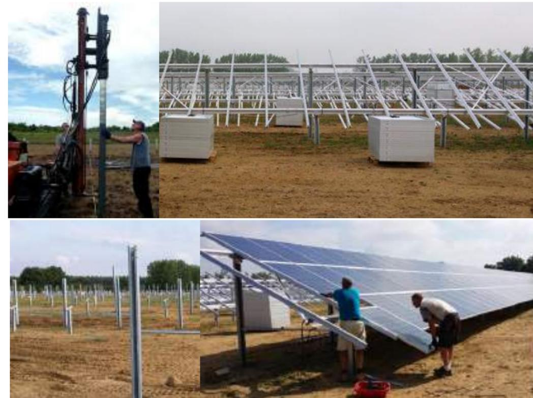
Figure 27. Fondations et ancrages
