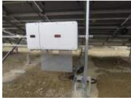
Figure 14. Exemple d'onduleur décentralisé (source NEOEN)
