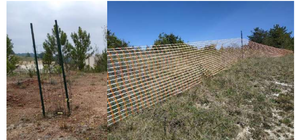
Figure 60. A gauche : Balisage avec grillage souple et piquets en acier A droite : Filet de chantier (source : CERMECO)
