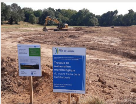
Site en travaux
