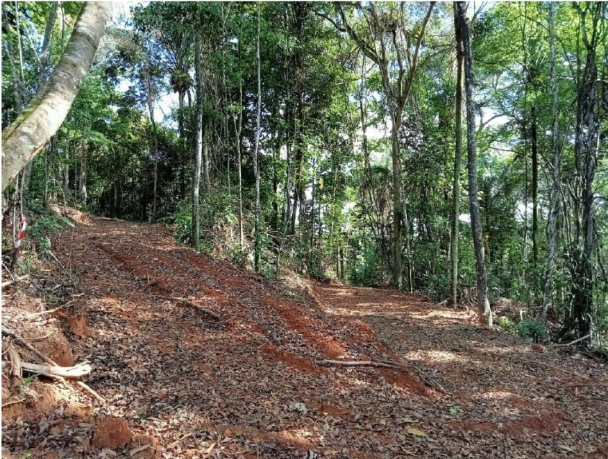
Larges travées ayant endommagé le sous-bois – Pelletier V.
