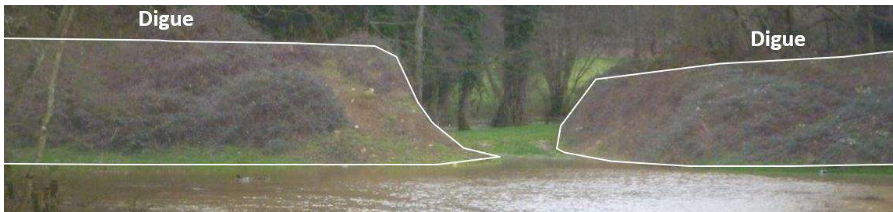
Figure 17 : Photographie et contour de la digue présente en aval du ruisseau
