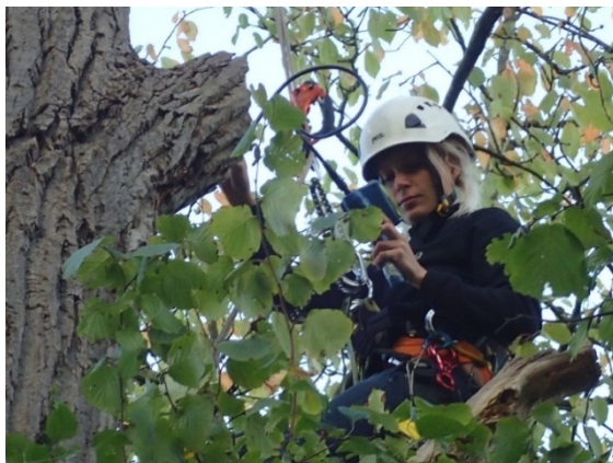
Figure 2 : Utilisation d'un endoscope pour l'inspection des cavités
