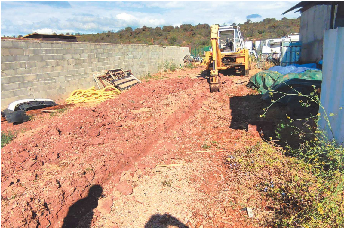
Vues de l'emplacement indiqué par l'exploitant comme futur zone imperméabilisée et de la tranchée de raccordement au décanteur / deshuileur
