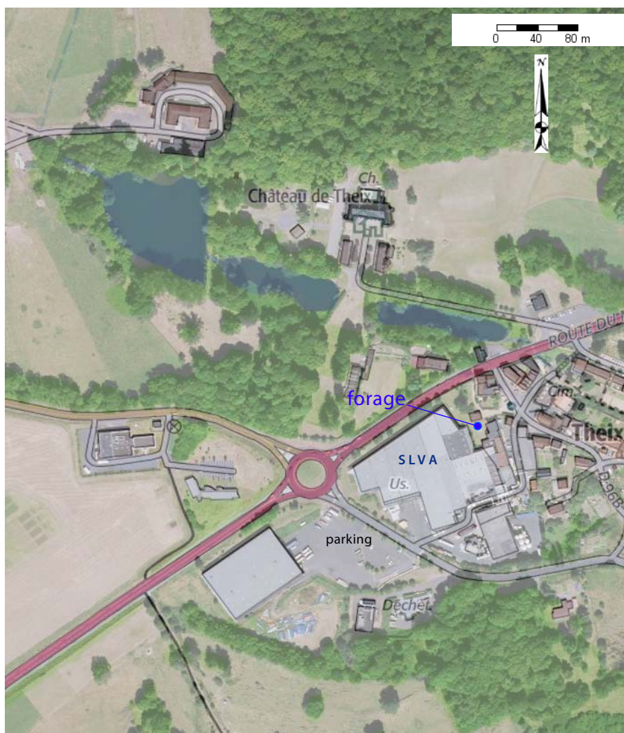
Figure 1 : situation du forage dans l'entreprise et de SLVA dans le bourg de Theix
