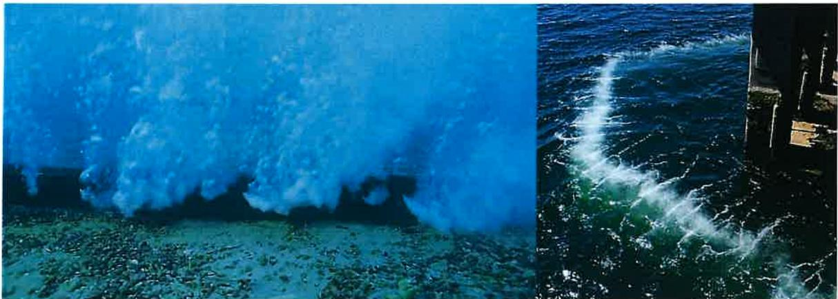
Figure 2 : Illustration de la mise en œuvre d'un rideau de bulles (vue depuis le fond à gauche, et de la surface à droite)
