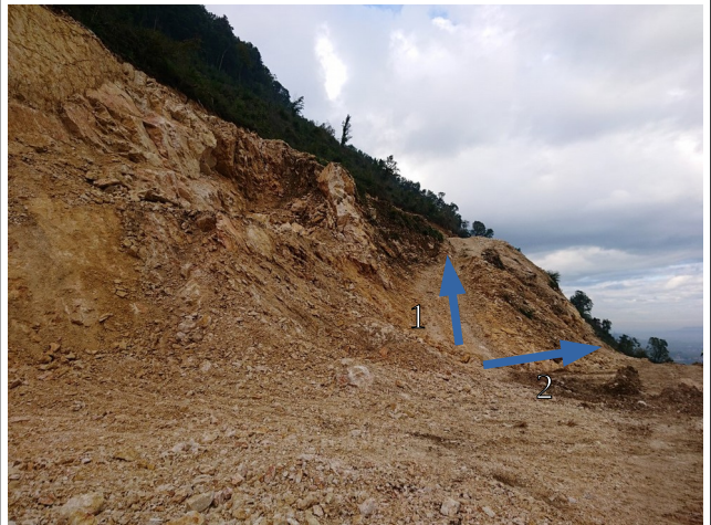
1 :Vers la future banquette supérieure au-dessus de la couche de glissement 2 : Banquette inférieure
