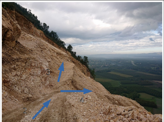
3 : Accès vers zone de glissement et plan de glissement 4 : Piste vers banquettes inférieures
