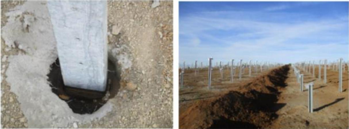
Figure 12. Exemple de fondation type pieux – Q ENERGY France
