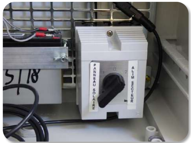
Positionnement du mode d'alimentation sur « secteur »
