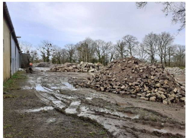
Stockage de matériel minéral en mélange avec des terres en partie nord du site
