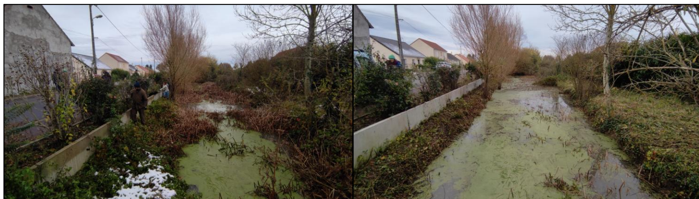
La mare avant et après les travaux © N. Déjean - Loiret Nature Environnement
