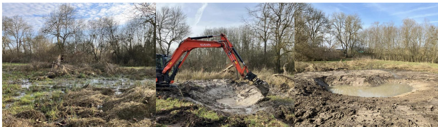
La mare avant travaux, pendant et après travaux © F. Laurenceau – Perche Nature
