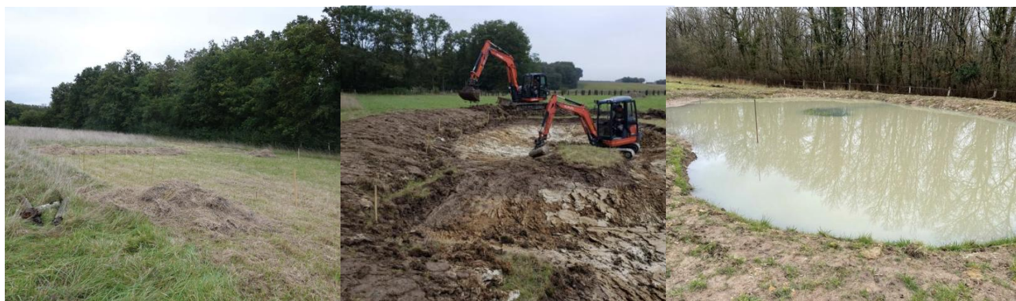
La mare avant travaux, pendant et après travaux © F. Laurenceau – Perche Nature
