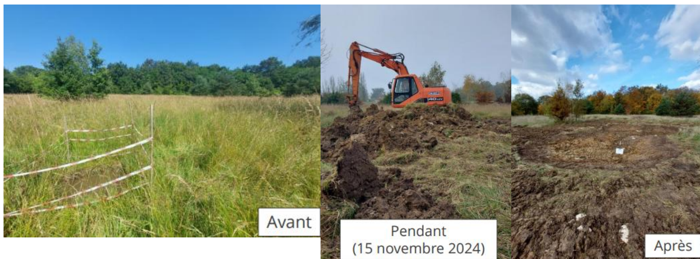
La mare avant, pendant et après travaux © M. Chatenier – CDPNE
