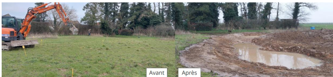
La mare après et avant travaux © PA. Lessault – CDPNE
