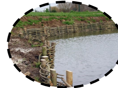
Fascinage pour protéger les berges érodées (www.gestiondifferentiee.org)
