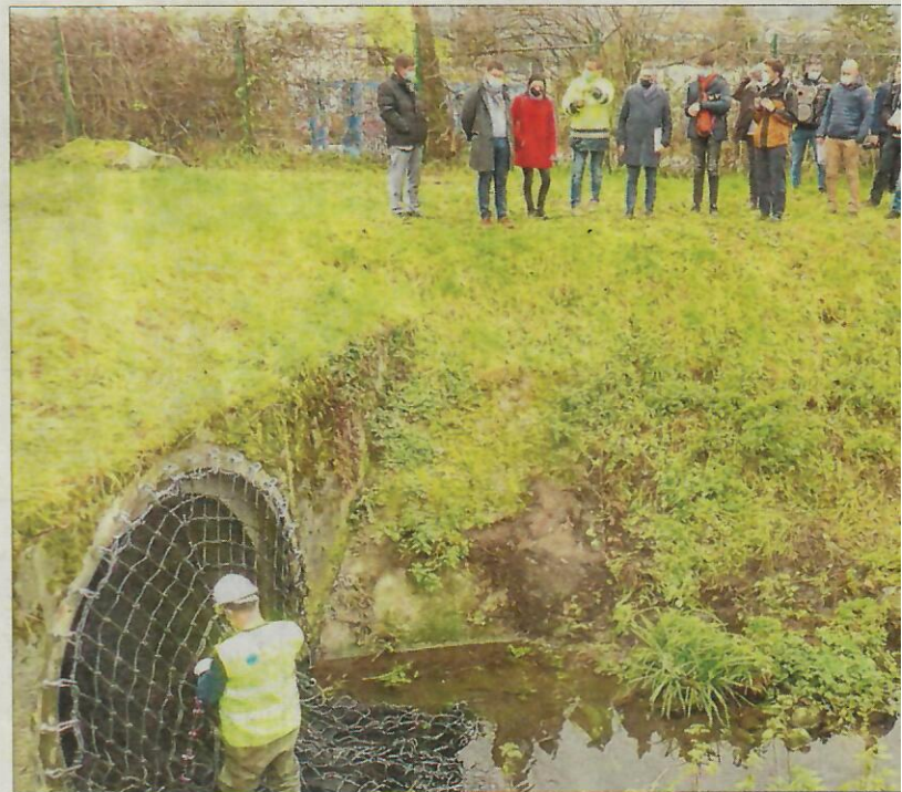
Un filet visant à capter les déchets à la sortie de la bouche d'évacuation a été installé afin de protéger le milieu aquatique. Photo Le DL/O.L.
