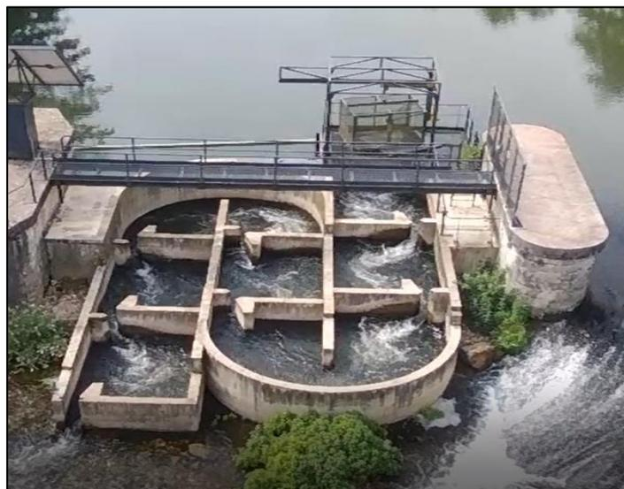
Figure 5 : Photos de la passe à poissons (Source : Consult Hydro)
