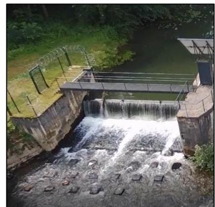
Figure 4 : Photo du clapet (Source : Consult Hydro)
