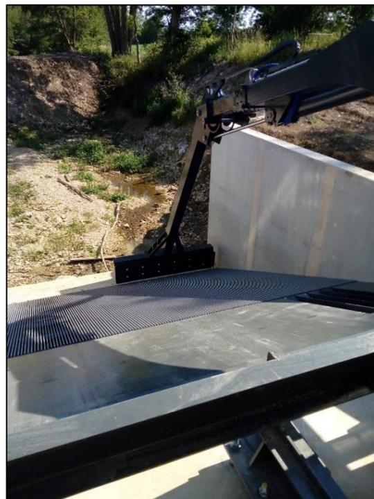
Figure 17 : Exemple de dégrilleur à bras articulé (Source : Consult Hydro)
