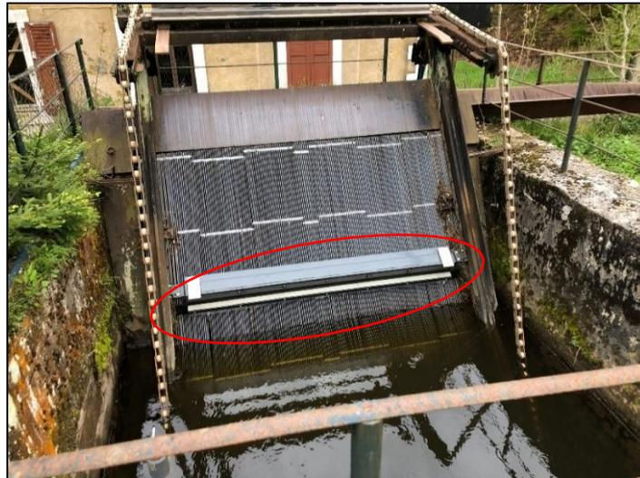
Figure 16 : Exemple de dégrilleur à chaîne (Source : Consult Hydro)
